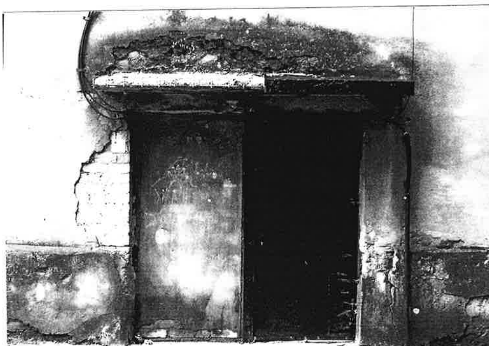
Fasadinių sienų tinkas suiręs, nukritęs, sienos drėksta, pelyja, peršąla
