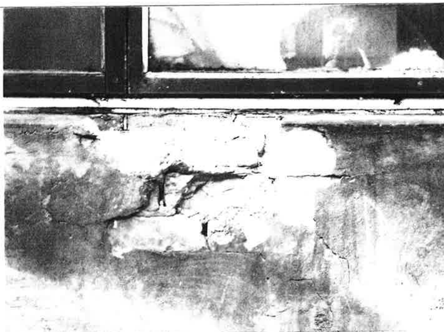
Fasadinių sienų tinkas suiręs, nukritęs, sienos drėksta, pelyja, peršąla
