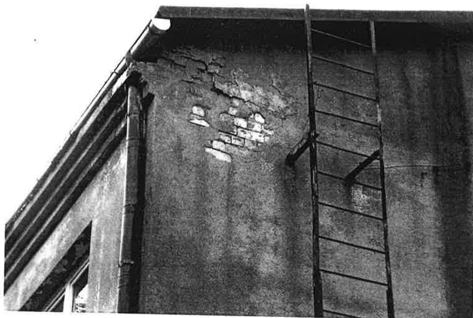
Fasadinių sienų tinkas suiręs, nukritęs, sienos drėksta, pelyja, peršąla
